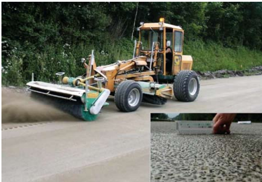
Bild 8 Ausbürsten des Oberflächenmörtels mit einem motorisierten Stahlbesen und ausgebürstete Fahrbahnoberfläche mit frei-liegender Gesteinskörnung 5/8 mm
