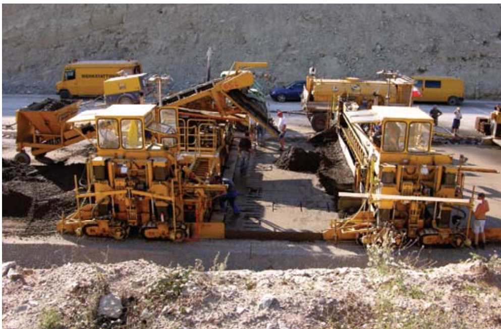
Obrázok 6 Dvojvrstvé ukladanie dvomi finišermi Heilit+Woerner s klznými bočnicami
