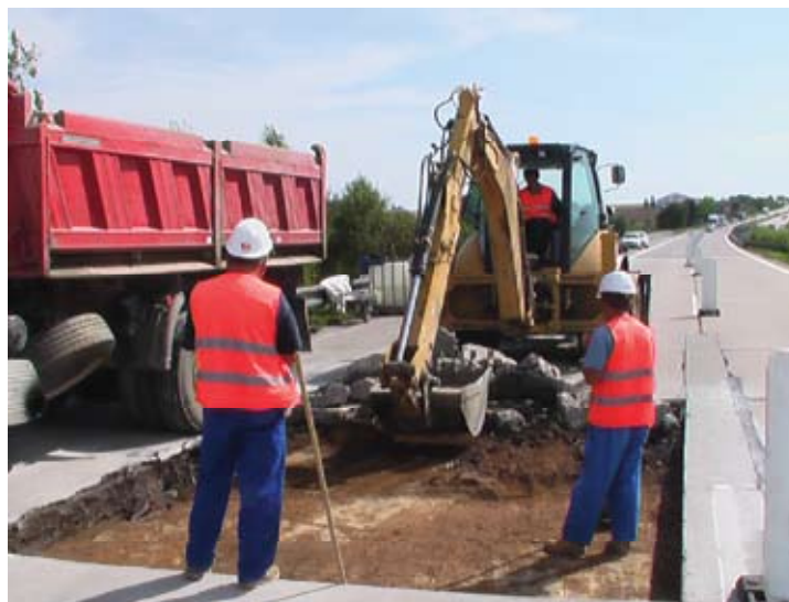
Obr. 1. Bourání staré poškozené betonové desky
