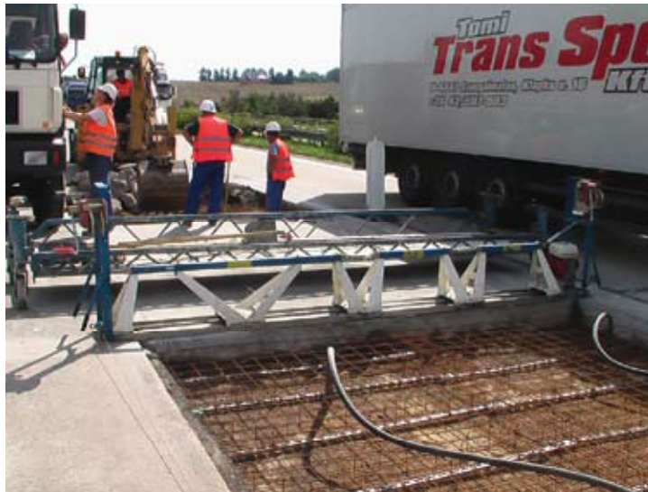
Obr. 2. Deska pripravená na betonáž
