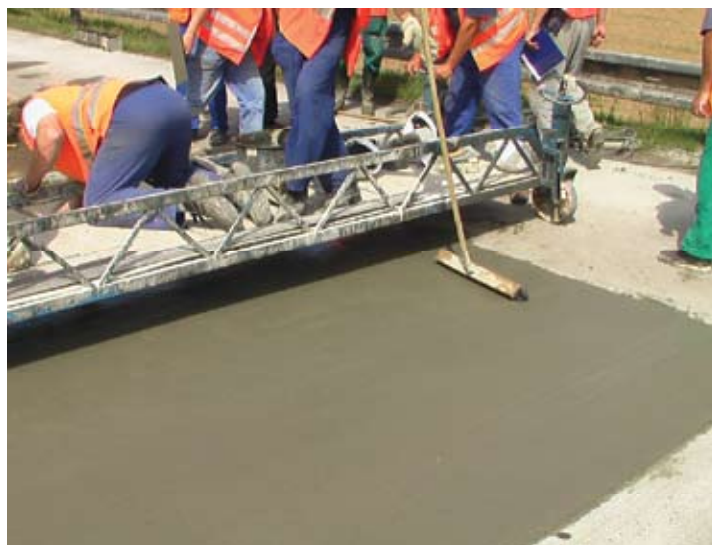
Obr. 4. Provedení zdrsnění povrchu vozovky
