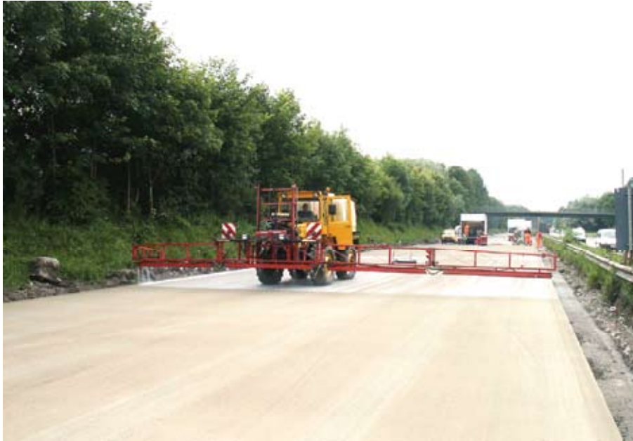
Bild 9 Weiterführende Nachbehandlung der ausgebürsteten Fahrbahnoberfläche durch Aufsprühen eines herkömmlichen Nachbehandlungsmittels von einem mobilen Trägergerät aus
