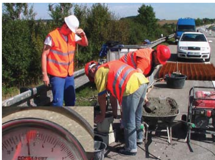
Obr. 6. V průběhu betonáže je prováděna řada kontrolních zkoušek a měření.
