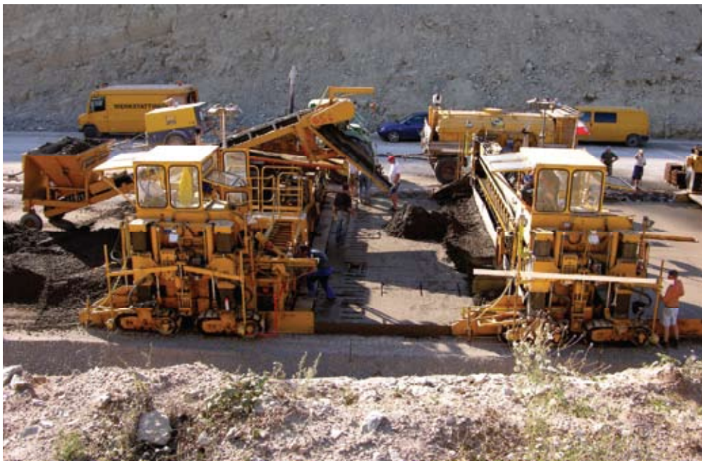
Bild 6 Zweischichtiger Einbau mit zwei Gleitschalungsfertigern von Heilit+Woerner
