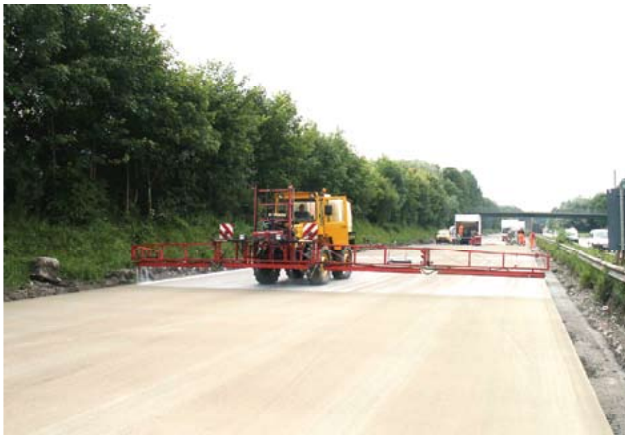
Obrázok 9 Nadväzujúce ošetrovanie kefami upraveného povrchu vozovky nastriekaním bežného ošetrovacieho prostriedku z mobilného nosníkového zariadenia
