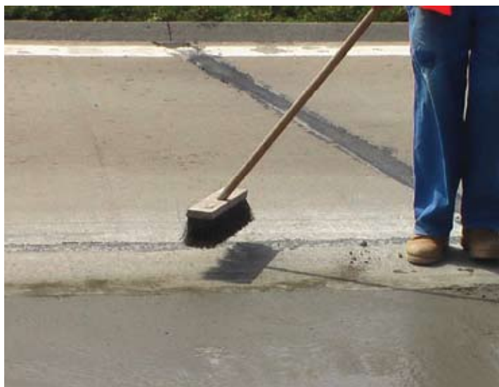
Obr. 5. Těsně po betonáži je důležité vše precizně uklidit.
