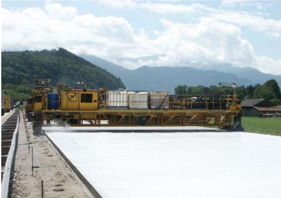
Bild 7 Aufsprühen eines kombinierten Verzögerungs- und Nachbe-handlungsmittels von einer Arbeitsbühne aus
