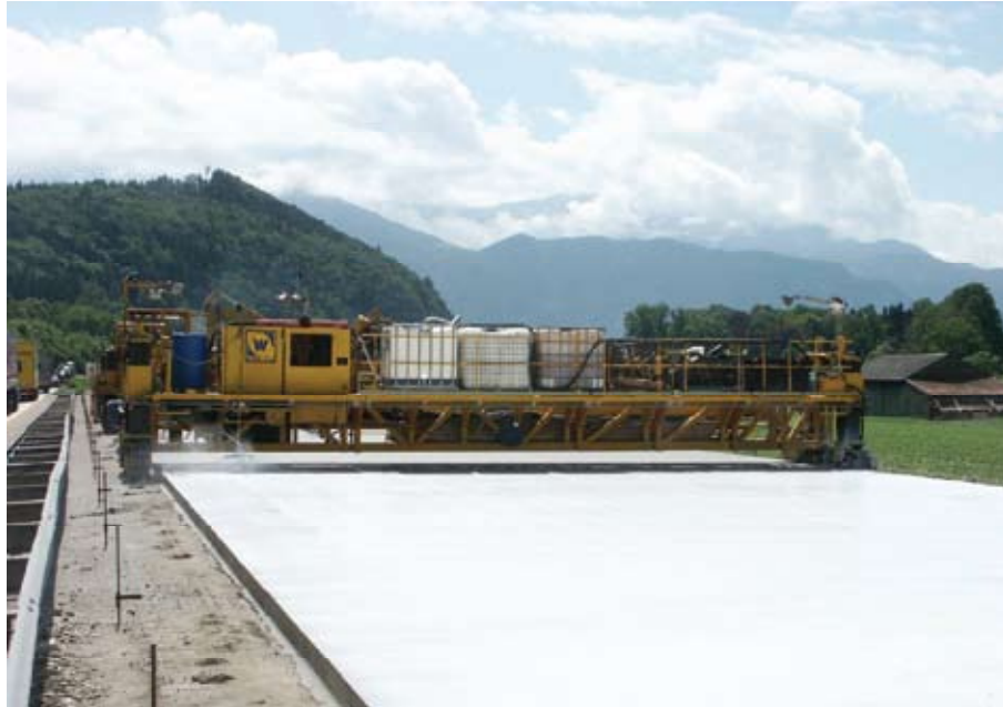
Obr. 7 Nastriekanie kombinovaného retardačného a ošetrovacieho prostriedku z pracovnej plošiny
