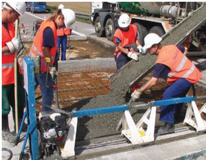
Obr. 3. Betonáž desky za pomoci „rychlých“ betonů
