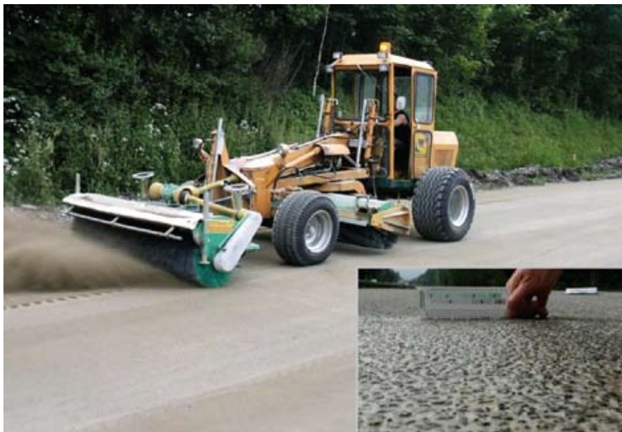
Obrázok 8 Odstraňovanie povrchovej malty kefami a motorom hnanou oceľovou metlou a upravený povrch vozovky s viditeľným kamenivom 5/8
