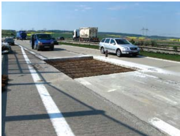
Obr. 1 Výměna cementobetonové desky technologií rychlých betonů - do 36 hodin
