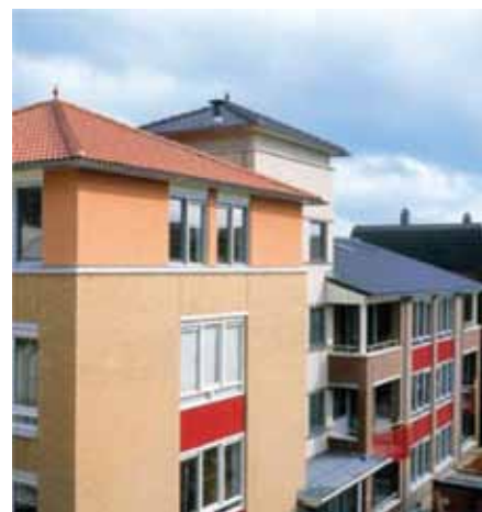
Holandská budova zhotovená z prefabrikátov. Betónová strešná krytina použitá na konečnú úpravu strechy zabezpečí dlhú životnosť budovy. S láskavým dovolením BFBN.
