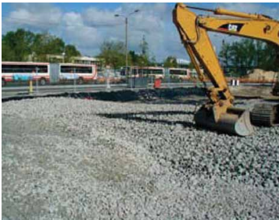
Zhodnotený odpadový materiál a rozdrvený odpadový betón môže byť použitý pri výstavbe ciest. S láskavým dovolením CERIB.
