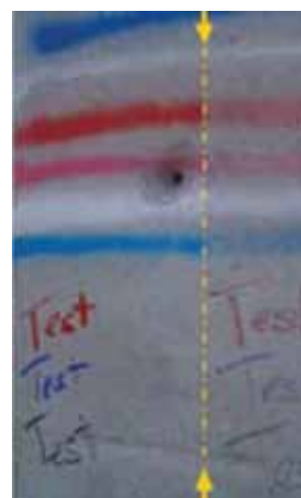
Rozdiel medzi časťami betónovej steny chránenými alebo nechránenými „anti-graffiti“ povrchovými úpravami. S láskavým dovolením Bêton [s].- le Magazine.
