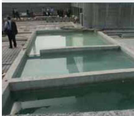
Pevné látky vo vode používanej pri výrobe v priemysle betónu je dovolené separovať (odlúčiť), a tak voda môže byť znovu použitá pri výrobe betónu. S láskavým dovolením časopisu „Betoni“, Fínsko.
