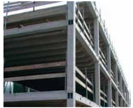
Demontovateľný skelet budovy v Holandsku. S láskavým dovolením BFBN.
