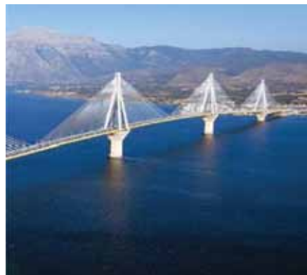
„Rion-Antirion“ zavesený most v Grécku je konštrukciou, ktorá volá po dlhej životnosti. Most je 3 km dlhý a stredné rozpätie je dlhé 560 metrov. S láskavým dovolením FIB.
