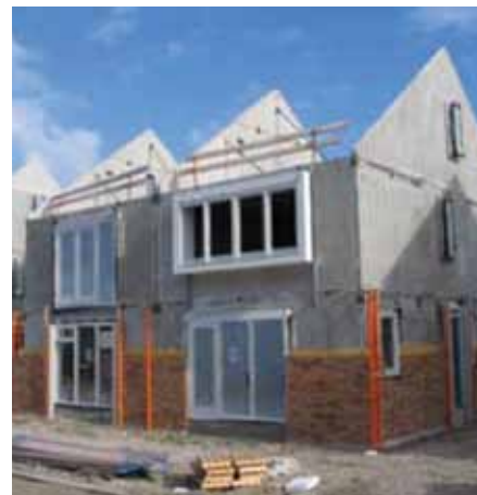
Tvarovky z ľahkého betónu sú široko používané v základoch a vonkajších stenách, pri výstavbe malých domov, pretože sa ľahko ukladajú a ľahko sa s nimi pracuje. S láskavým dovolením BFBN.
