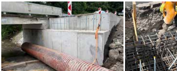
Obr. 7: Pohľad na oporu mosta M3415 z betónu z recyklovaného kameniva so 100% náhradou hrubej frakcie kameniva – prvá slovenská aplikácia v inžinierskej stavbe.
