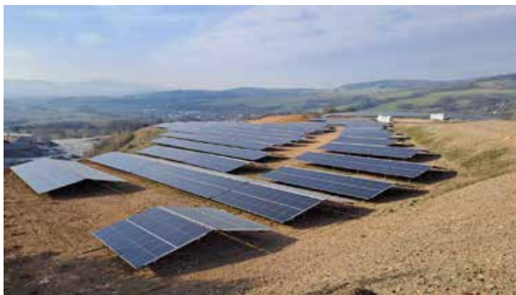
Obr. 2 Výstavba panelových polí na pozemnej konštrukcii
