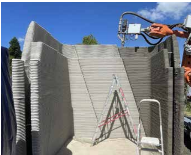
Obrázek 4 – Průběh tisku
