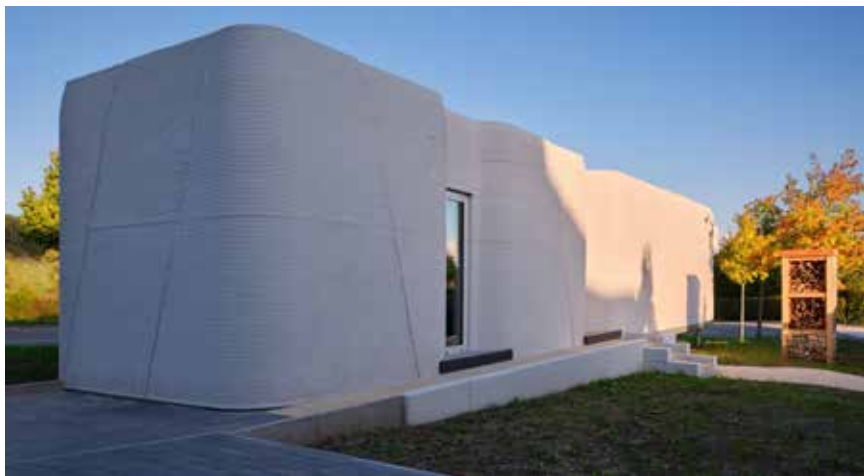
Obrázek 1 - Exteriér prototypového 3D tištěného domu Tiny House Lux
