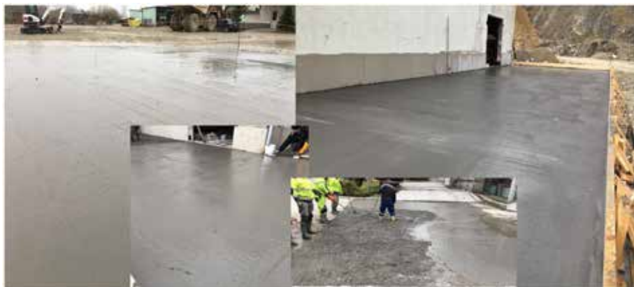
Obr. 2 – betonáž v areáli PCLA a.s. Ladce
